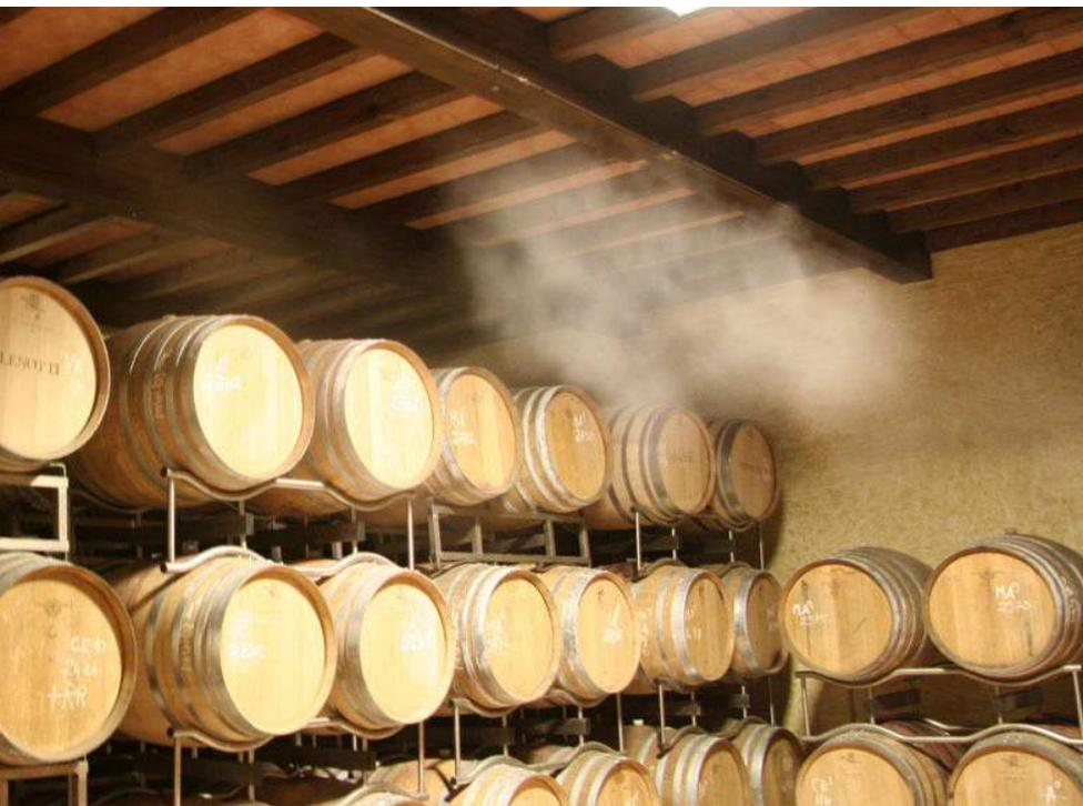
El sistema de humidificación por alta presión MERLIN garantiza las condiciones óptimas para los procesos de conservación, almacenamiento, etc. en la industria del vino.
